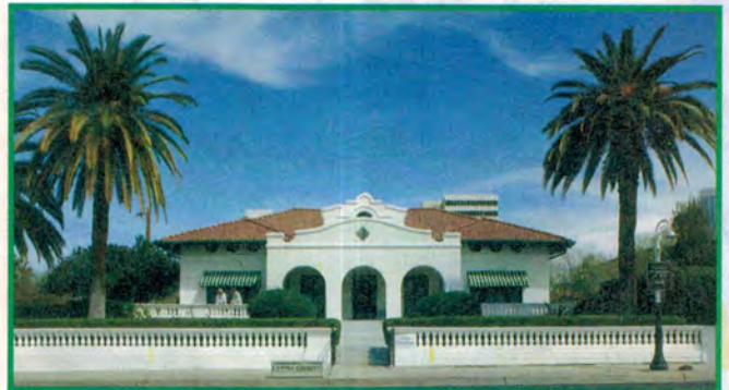
La Casa J. Knox Corbett en el distrito histórico de Tucson, Arizona
